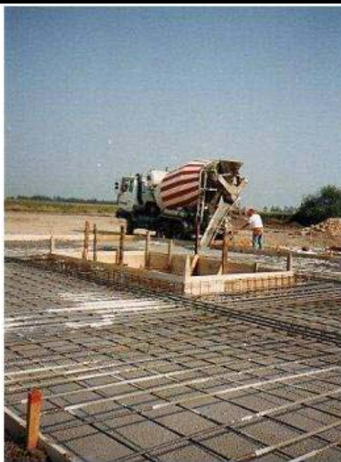
Esempio di Costruzione Solettone e Cantina
